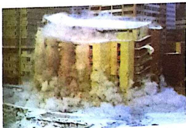
27.7 - رەسىم. پارتلاتقۇچ دورىدىن پايدە- لىنىپ قەۋەتلىك بىنانى نشانلىق پارتىلتىپ ئۆرۈش
